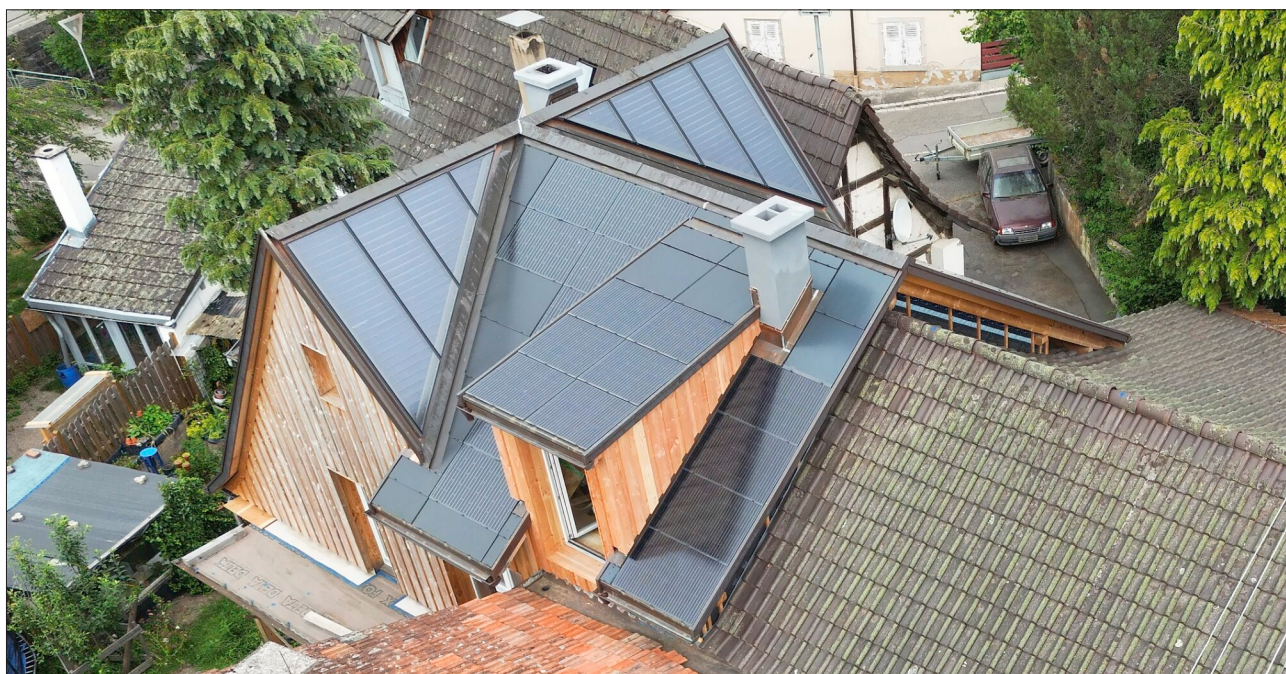
Das Dach von Fabian Hombergs Haus ist mit integrierter Solar-Anlage sowie integrierter Solarthermie gedeckt.
